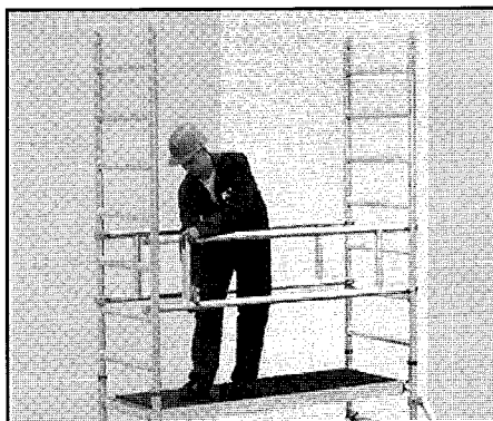
Abb. 23 Geländerrahmen einsetzen
