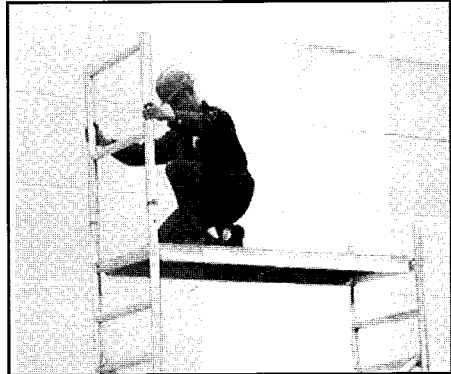
Abb. 27 Geländer einsetzen
