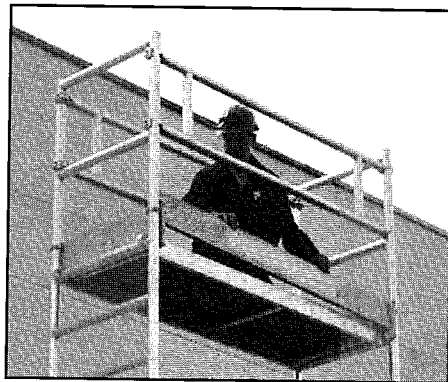
Abb. 30 Bordbrett einsetzen
