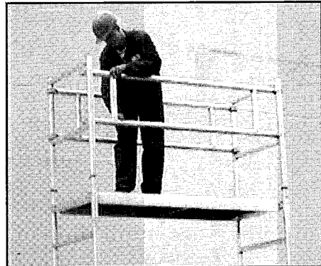
Abb. 28 Geländerrahmen einsetzen
