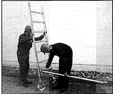
Abb. 15 Horizontalstreben anbauen
